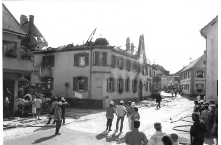
Fassungslos standen die Bürger vor der Ruine.
