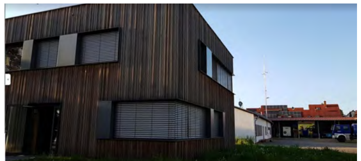
In Kenzingen befindet sich Südbadens größter THW-Standort..
