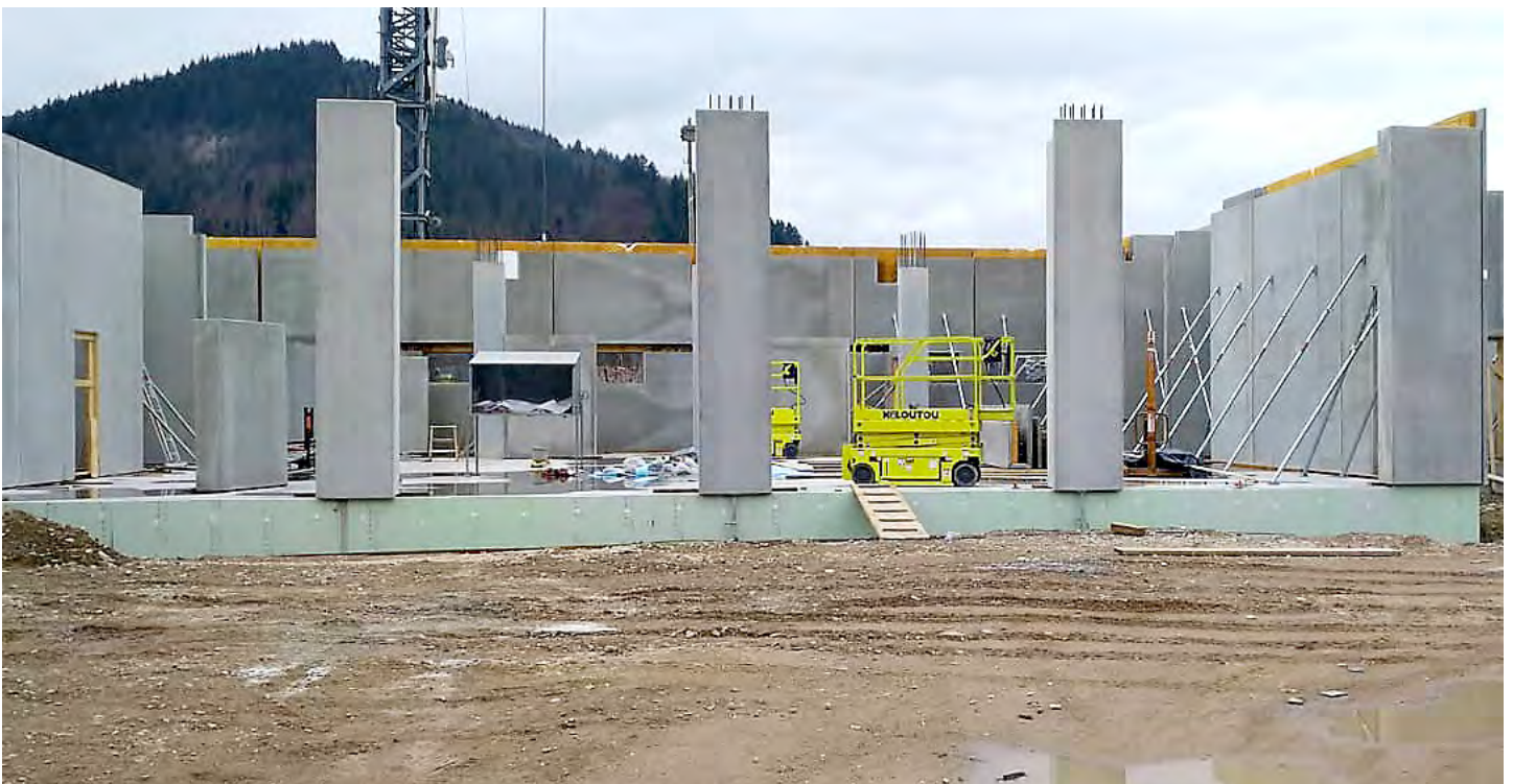
Das 4,55 Meter hohe Erdgeschoss wurde in funktionaler Betonbauweise errichtet.
