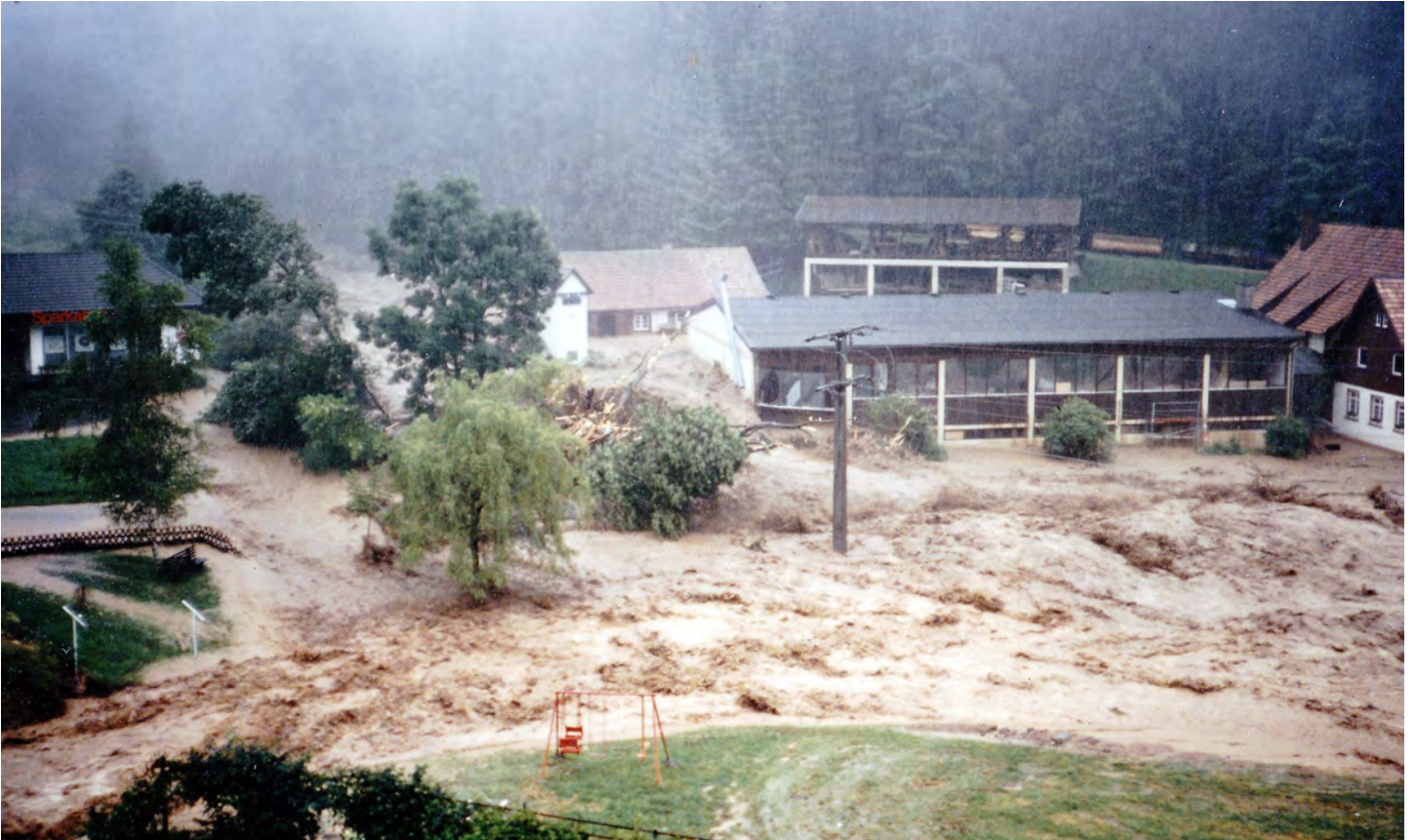
Besonders stark betroffen war die Schreinerei Reinbold am Sägplatz. Das Gebäude wurde durch die Wassermassen und die mitgeführten Baumstämme zerstört und nahezu alle Maschinen mitgerissen, die sich später teilweise in Sexau oder im Bereich der Hochburg wiederfanden.
