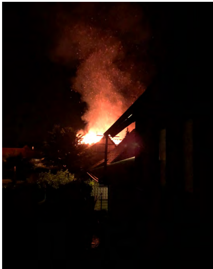
Der offene Dachstuhlbrand war weithin sichtbar.
