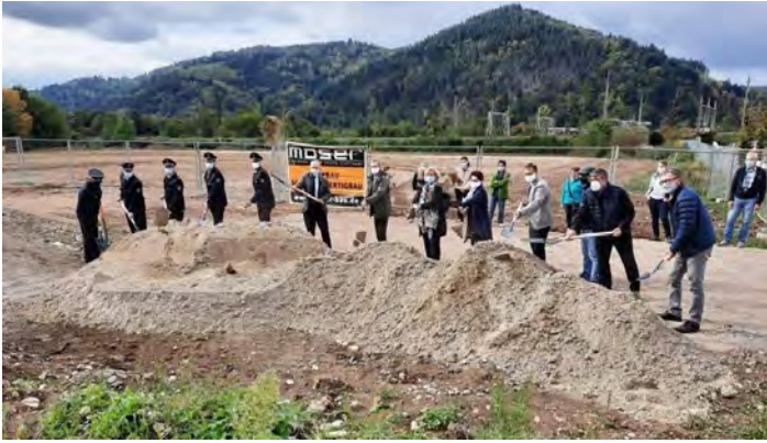
Im Oktober 2020 wurde der Spatenstich vorgenommen...
