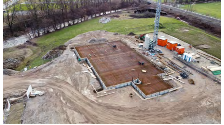
...schon Wochen später lag die Bodenplatte.
