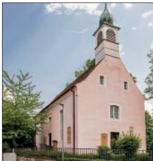
Die Magarethenkapelle soll saniert werden.
