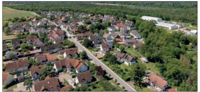
Zwischen 2021 und 2022 wurde die Landesstraße L 134 erneuert. Foto: zVg
